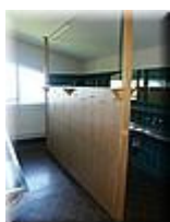
EM 052 Waschraum 2.OG
