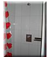
EM 043 Duschraum 2.OG 02
