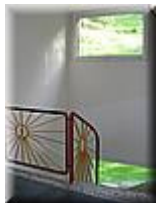
EM 040 Treppenhaus 2.OG
