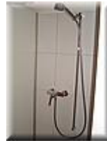
EM 007 WC mit 2 Duschen EG
