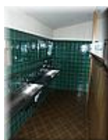
EM 053 Waschraum 2.OG
